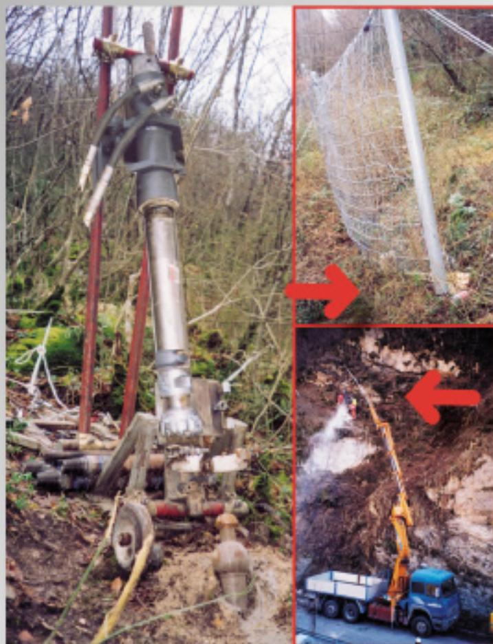
↓ **MICRO SLITTA DI PERFORAZIONE** per l'impiego di martelli fondo foro Ø 110. L'altrezzatura illustrata è stata impiegata per eseguire i fori in alta montagna per l'installazione dei pali porta rete paramassi.
